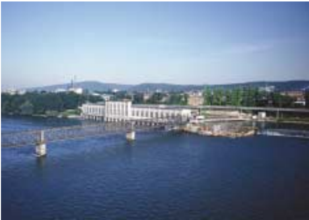
Laufwasserkraftwerk Rheinfelden (Rhein)
