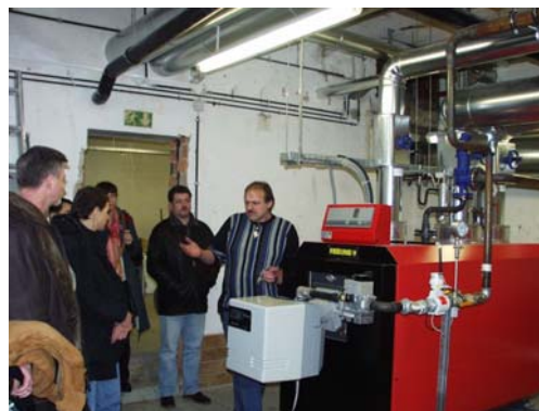
Energierundgang Bettina-Schule Frankfurt am Main
